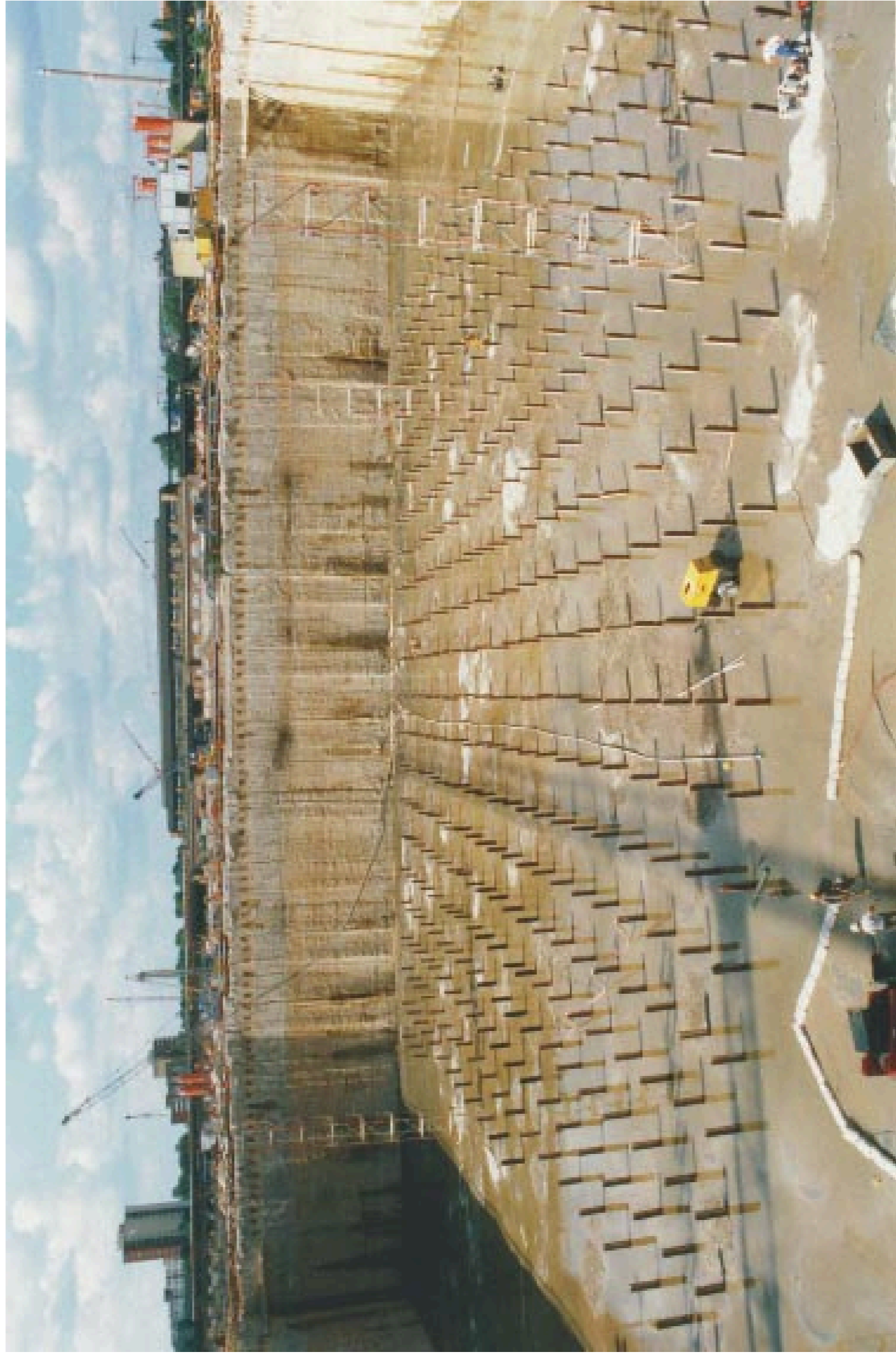
Bild 1: Trogbaugrube mit Unterwasserbetonsohle und RI-Pfahl-Verankerung
